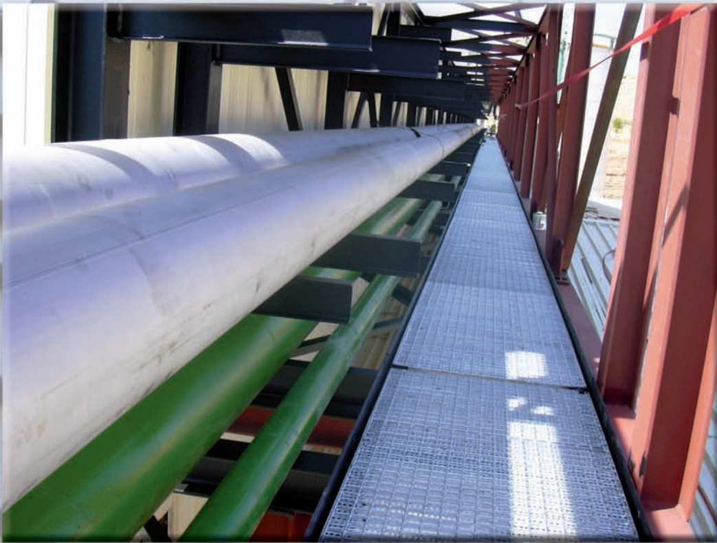
Instalación de estructura metálica y Rack de tuberías
