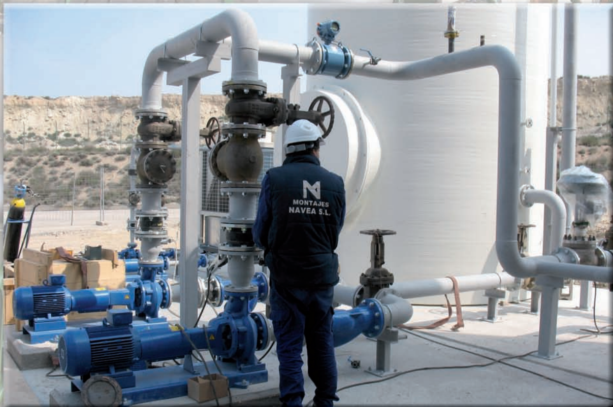
Planta de refrigeración
