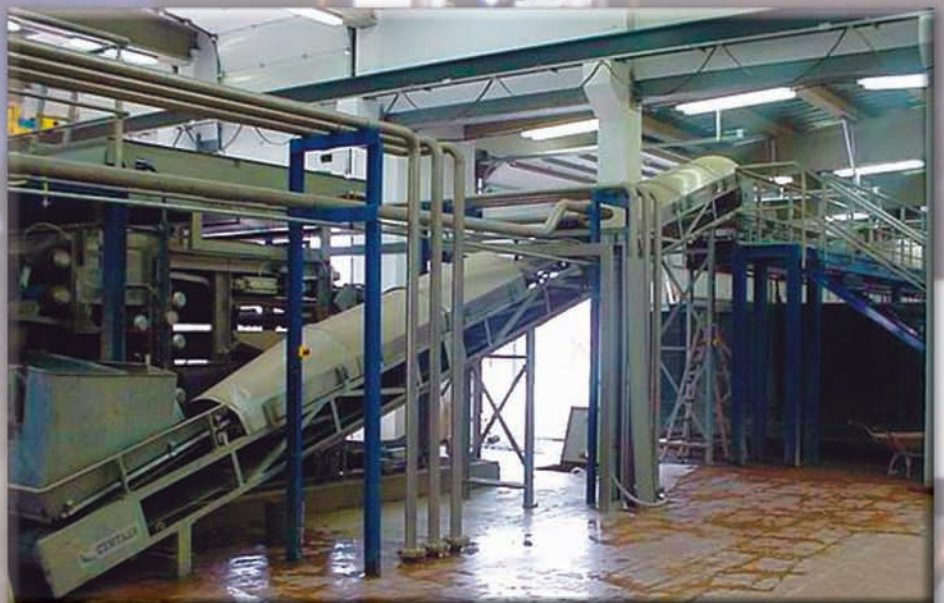
Montaje y mantenimiento de equipos para instalaciones industriales en planta potabilizadora
