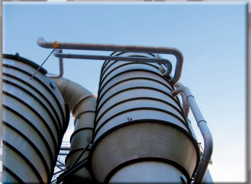
Montaje de depósitos e instalación de tubería inoxidable para productos químicos
