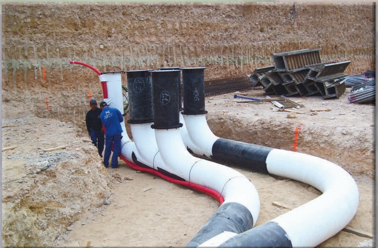
Montaje de red general en tubería de diámetro 500 para recogida neumática de basura
