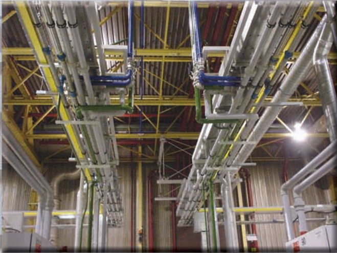
Instalación de tubería y soportación
