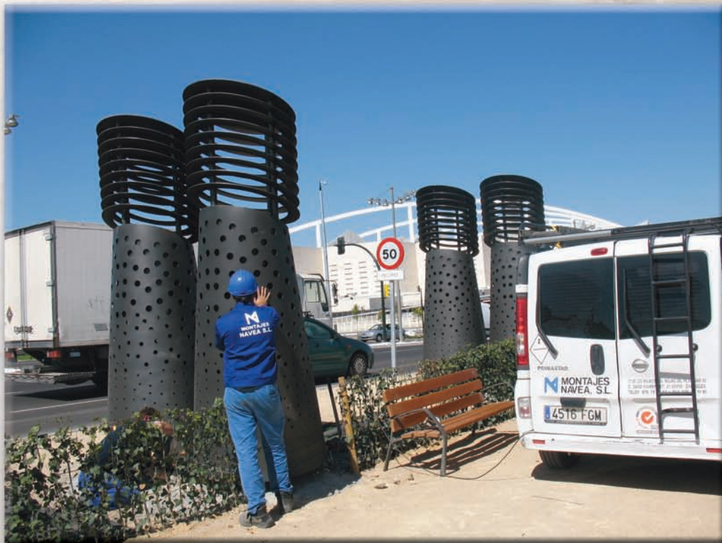
Fabricación de piezas de calderería y su montaje
