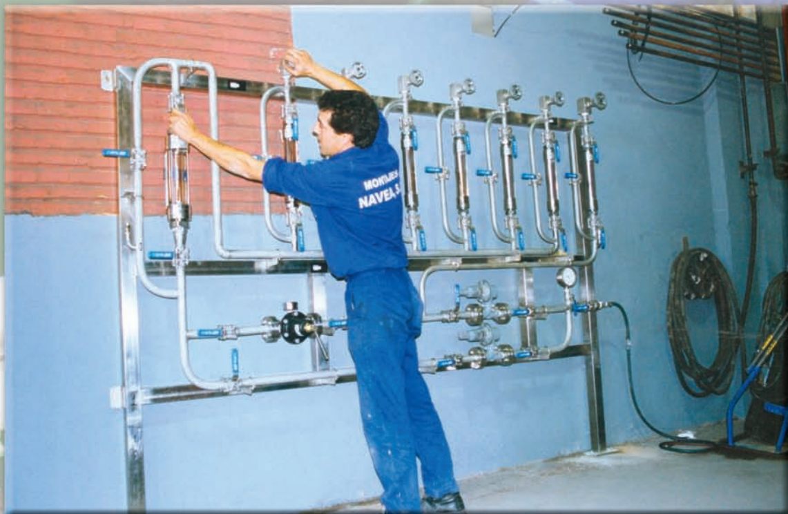
Instalación de tubing para laboratorio
