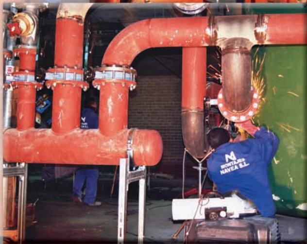
Instalación de tuberías para climatización y A.C.S.
