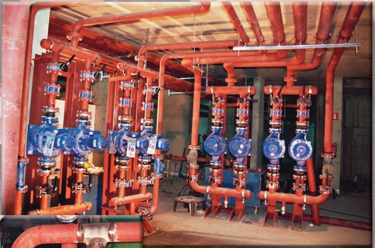
Instalación de tuberías para climatización y A.C.S.
