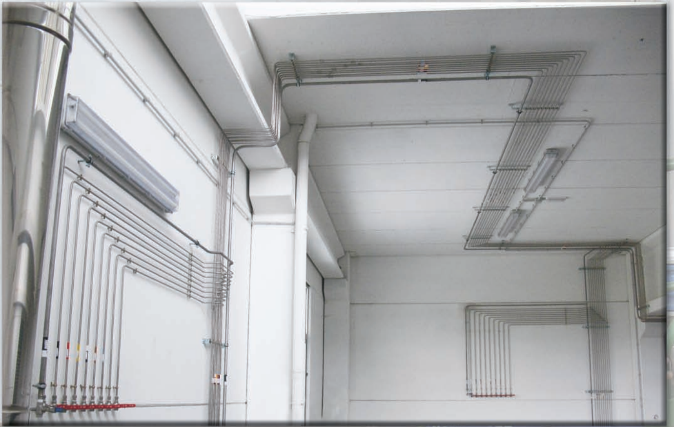
Instalación de tubing para laboratorio
